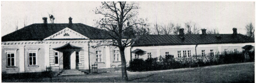
Abb. 7. Zentralschule in Grunau
